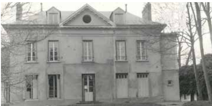
Château du Cèdre avant sa démolition
